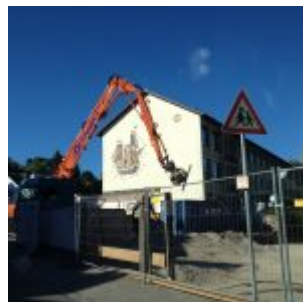
Bauarbeiten während der Sommerferien 2016 – Anbau Kampmannstraße fehlt
