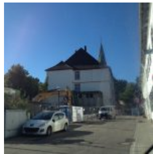
Bauarbeiten während der Sommerferien 2016 – Blick in die Kirchstraße
