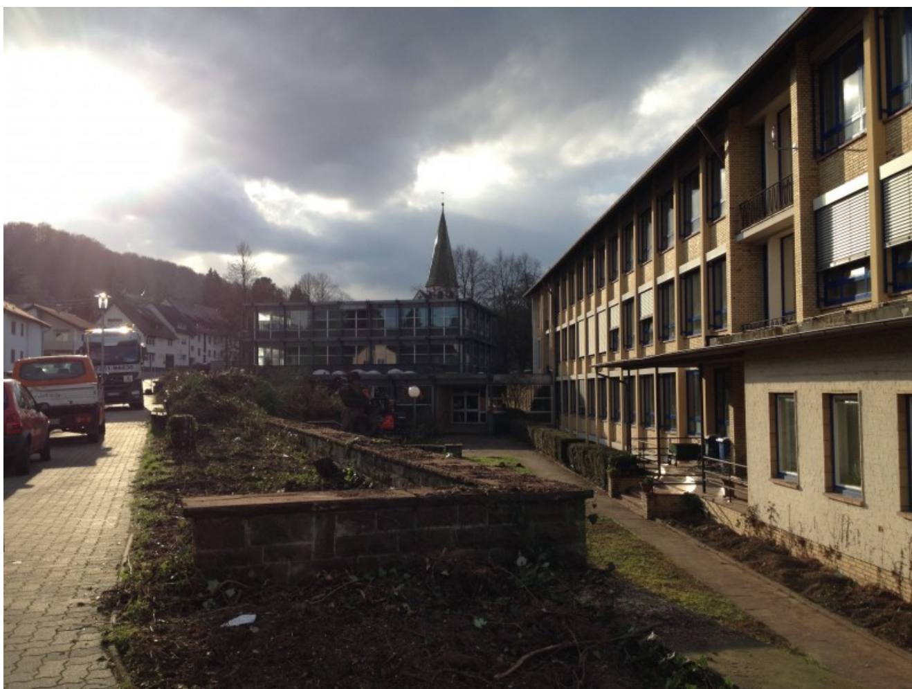
März 2016 – vor den Baumaßnahmen – Blick auf die Kirche von der Staigstraße
