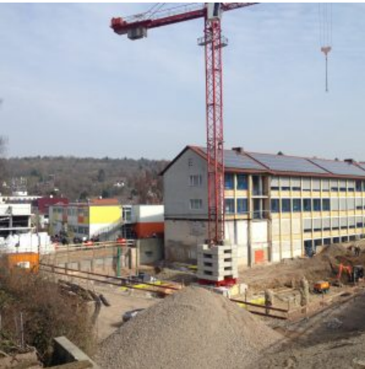
Blick in die Baugrube von der Staigstraße auf den HD-Bau
