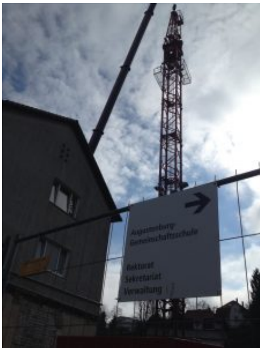
Der erste Baukran steht
