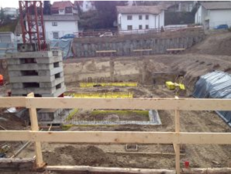
Blick in die Baugrube, erste Fundamente sind gegossen
