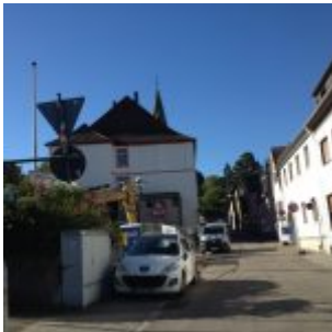
Bauarbeiten während der Sommerferien 2016 – ehemaliges Schulmuseum Kirchstraße
