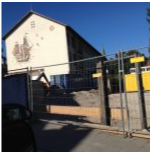
Bauarbeiten während der Sommerferien 2016 – Blick auf den HD-Bau
