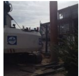
Erste Tragsäulen werden eingebracht ins Erdreich
