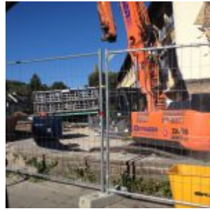
Bauarbeiten während der Sommerferien 2016 – schweres Gerät im Einsatz
