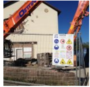
Bauarbeiten während der Sommerferien 2016 – Bauarbeiten im vollem Gange
