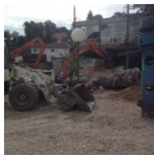
Fast geschafft der Abriss!
