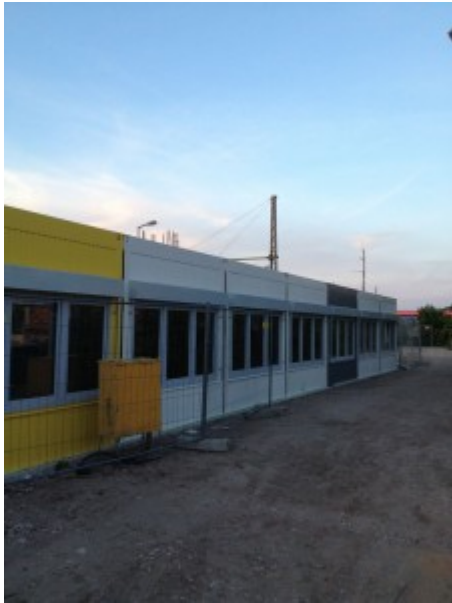
Container 3 wird aufgebaut, 25.6.2015
