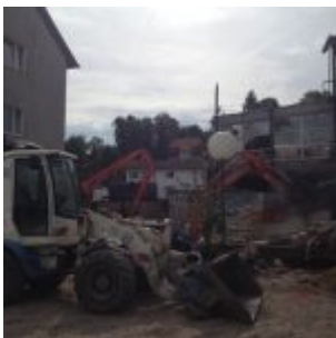
Schweres Gerät im Einsatz während der Sommerferien 2016
