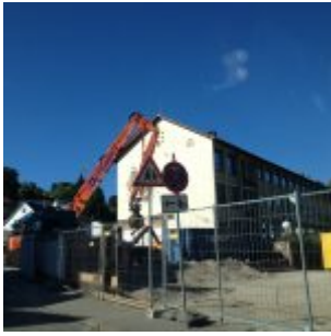
Bauarbeiten während der Sommerferien 2016 – Schulhofeingang Kampmannstraße
