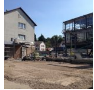
HD Bau vor Staigstraße neben Glasgebäude
