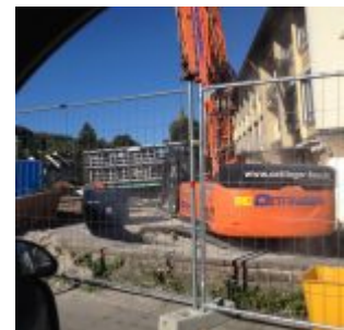
Bauarbeiten während der Sommerferien 2016 – Hausmeisterwohnun g fehlt
